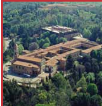
Veduta aerea del Complesso di San Michele in Bosco
