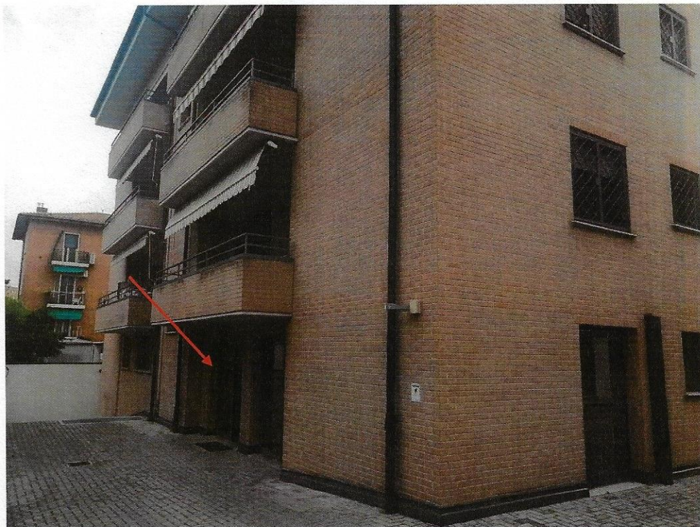
2 – ingresso al condominio
