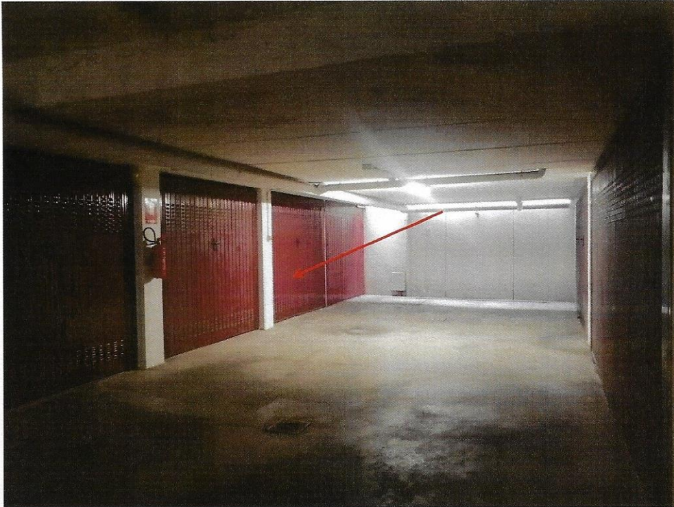
3 - vista del corsello comune - autorimesse con indicazione dell'accesso al sub 33
